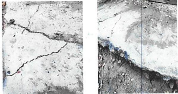
FOTO 6: FUNDIR DE NUEVO EL PISO PORQUE YA ESTÁ MUY RAJADO Y SE ESTÁ LEVANTANDO
